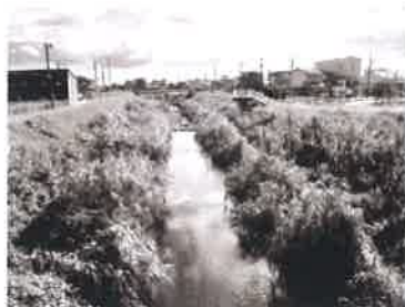
地藏川放水路 この先に内津川
