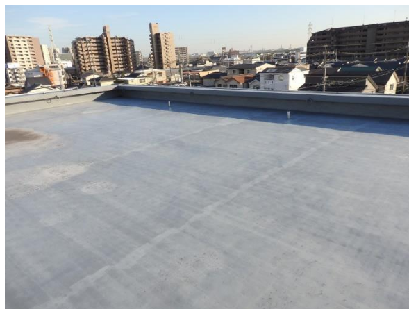
【山王小学校南館校舎屋上 南東を向いて】
