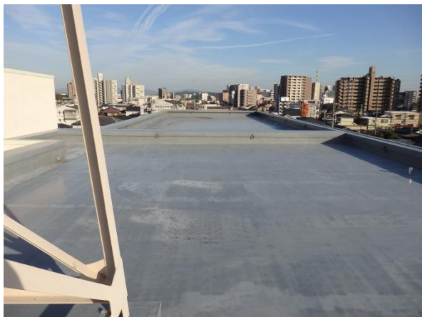
【山王小学校南館校舎屋上 東を向いて】
