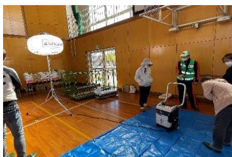
発電機(カセットポンプ使用)とLED 投光器
