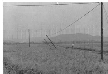
出川付近の有線放送電話の電柱が傾いている様子
