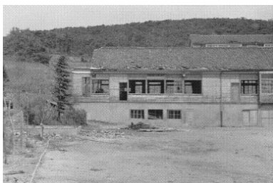
高座小学校 伊勢湾台風の影響で屋根や窓、壁が破損している。
